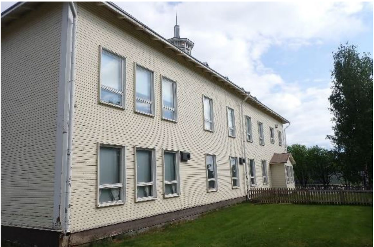
Kuva 7. Suojala luoteesta päin kuvattuna.
