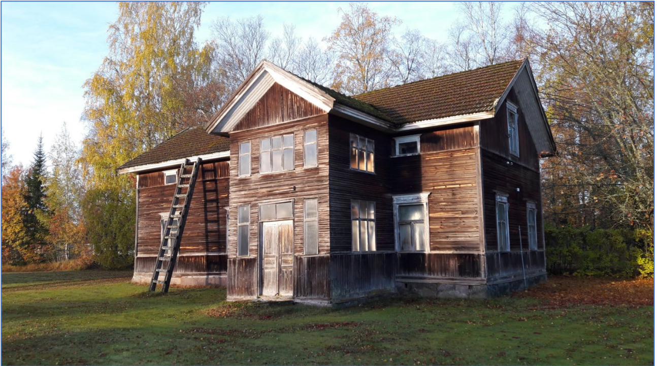
Kuva 10. Alaleskelä idästä päin kuvattuna.
