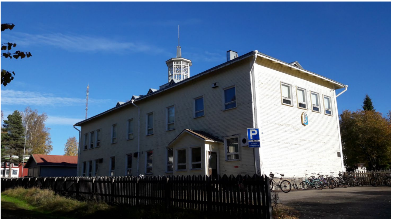
Kuvapari 5. Suojala lounaasta päin kuvattuna.
