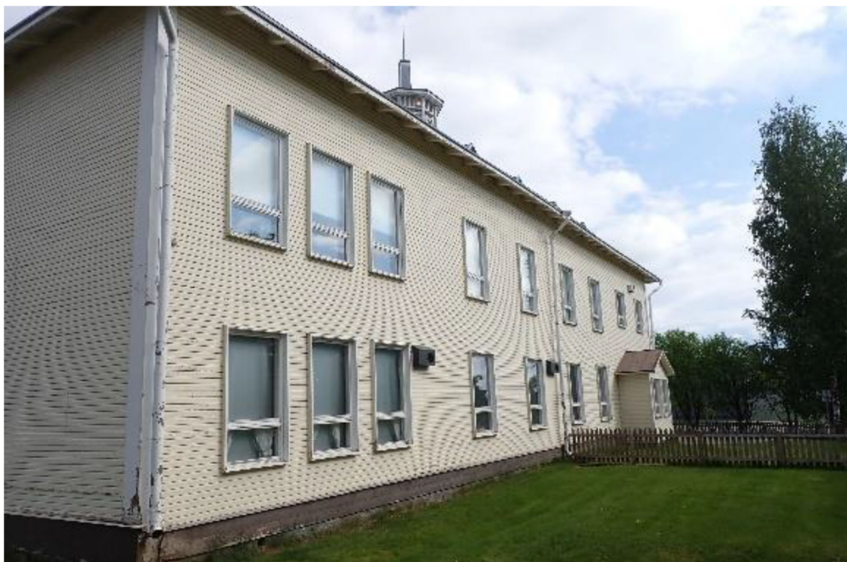
Kuva 7. Suojala luoteesta päin kuvattuna.
