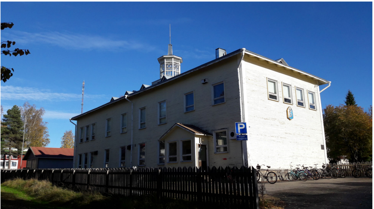
Kuvapari 5. Suojala lounaasta päin kuvattuna.
