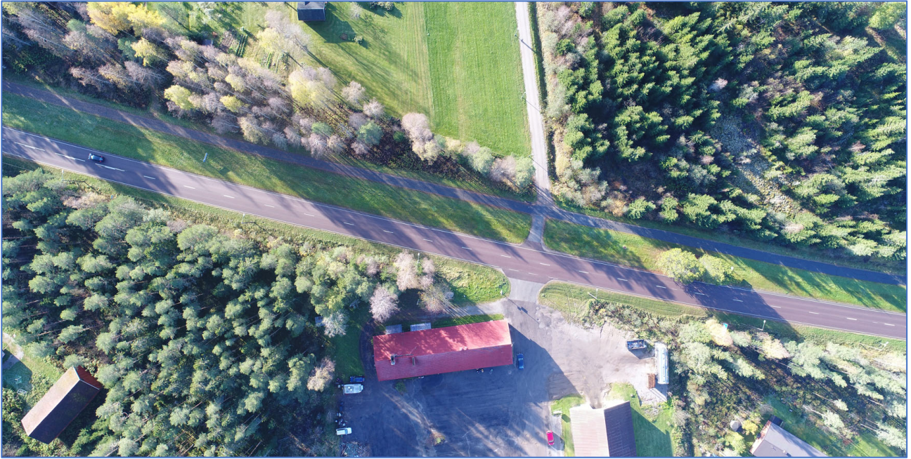
Kuva 7. Ilmakuva Lestintien liittymästä suunnittelualueelle. © Plandea Oy
