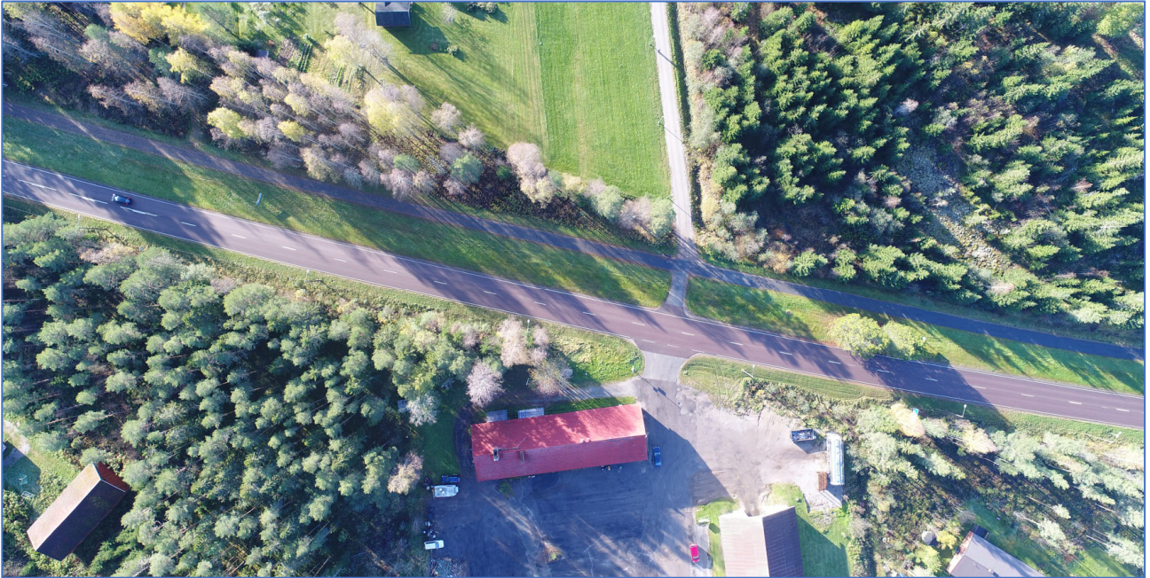
Kuva 7. Ilmakuva Lestintien liittymästä suunnittelualueelle. © Plandea Oy
