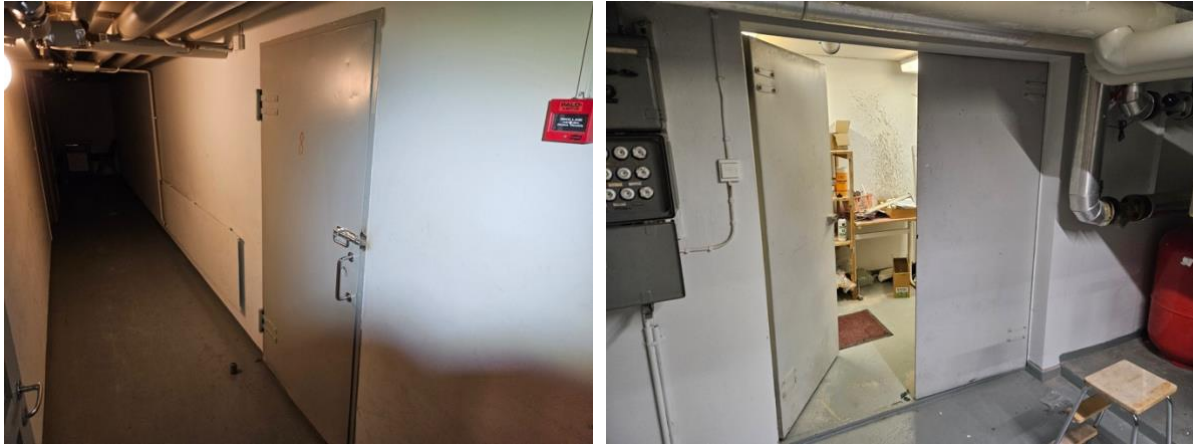
Kuvat 25 ja 26. Kellarin ja lämmönjakohuoneen vanhoja palo-ovia.
