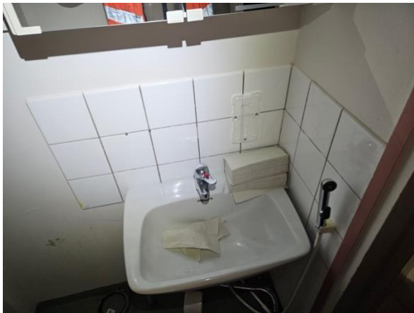
Kuva 18. Asuntojen alkuperäiskuntoiset WC-tilat, vesipisteiden takana laatoitus.
