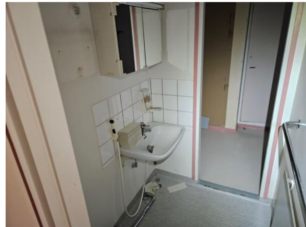
Kuva 19. Asuntojen alkuperäiskuntoiset WC-tilat, vesipisteiden takana laatoitus.
