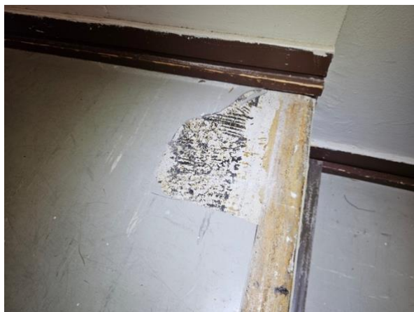
Kuvat 11 ja 12. Peruskorjatun osan sisäänkäynnin lattiassa on alkuperäinen muovimatto ja sen alla mustaa pikiliimaa.
