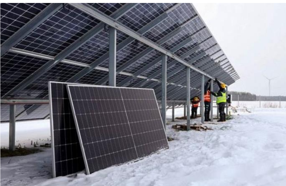
Kuva 6. Paneelit asennetaan 30 asteen kulmaan (kuva Helsingin Sanomat)
