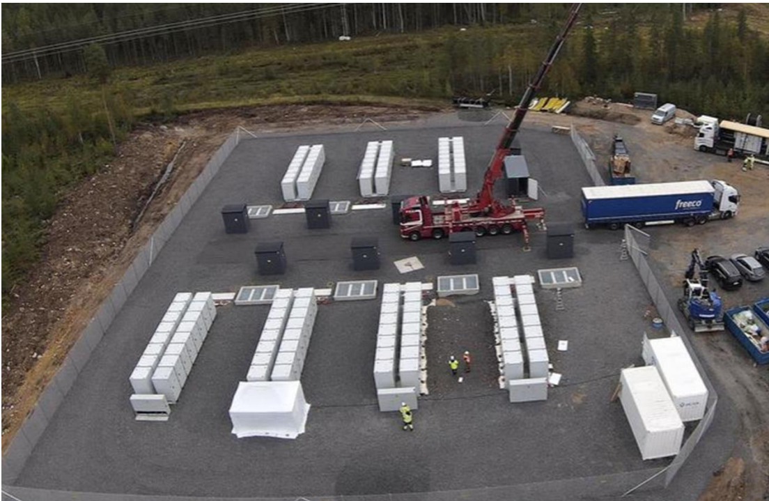
Kuva 7. Kuvituskuva: Akkujärjestelmä rakentuu (Kuva: Kauppalehti)
