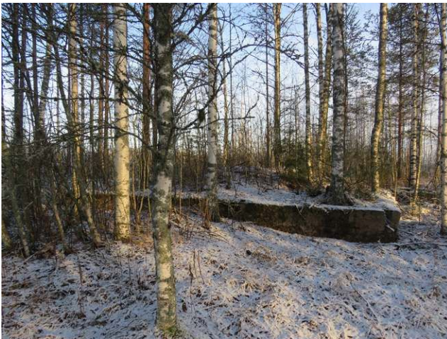
Perustuksen kaakkoisnurkka, kuva pohjoiseen.
