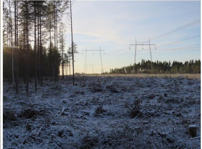
Kuva 30. Voimalinja Pirttinevanpalon kohdalla.
