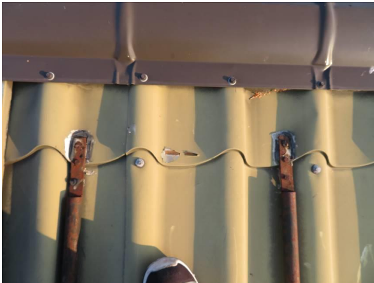
Kuva 33: Tikkaiden kiinnitys harjalla on heikko.
