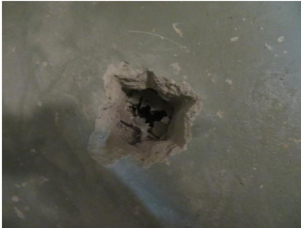
Kuva 11: Alapohja-avaus kellarissa, rakenne ei ole alkuperäinen
