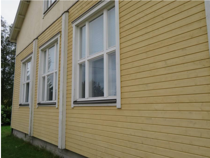
Kuva 17: Luokkatilojen uudemmat ikkunat ovat hyväkuntoisia.
