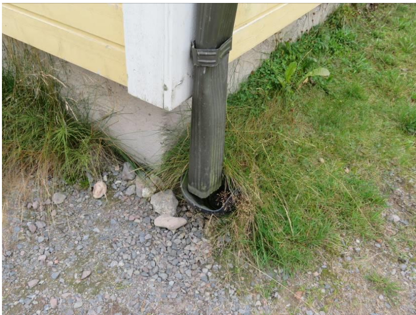
Kuva 30: Sadevesikourut on ohjattu rännikaivoihin.
