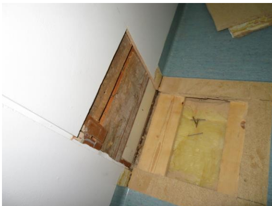
Kuva 9: Ulkoseinäavaus luokassa 21,5m 2
