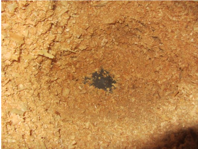
Kuva 14: Yläpohjan eristekerros
