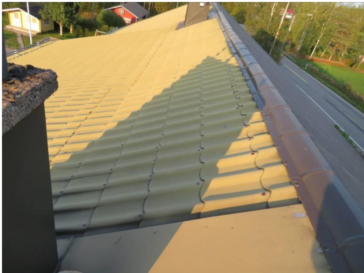
Kuva 27: Peltikate on silmämääräisesti arvioituna hyvässä kunnossa.
