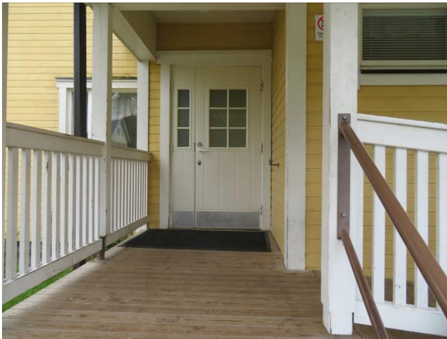
Kuva 18: Ulko-ovet ovat hyvässä kunnossa.
