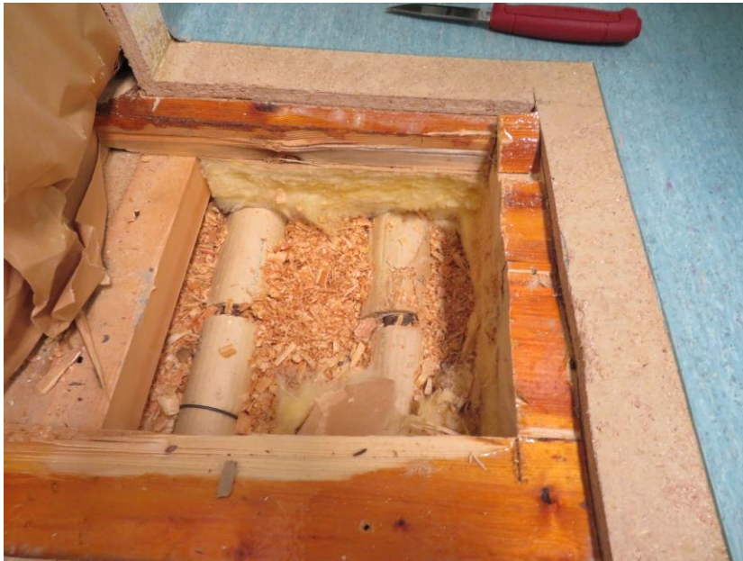
Kuva 10: Välipohjan avaus luokassa 21,5m 2
