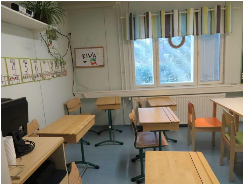
Kuva 20. 1. kerroksen muovimatto on hyvässä kunnossa.
