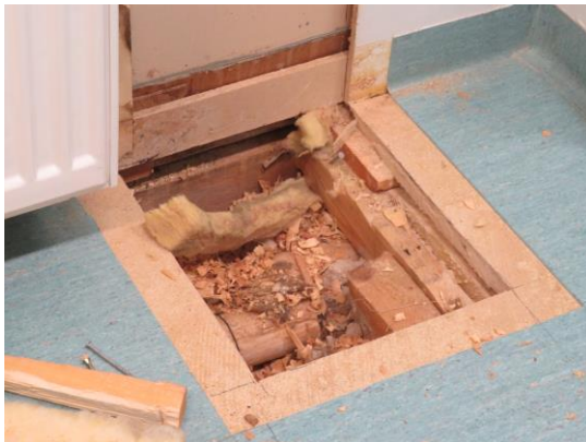
Kuva 12: Alapohja-avaus luokassa 55,0m 2
