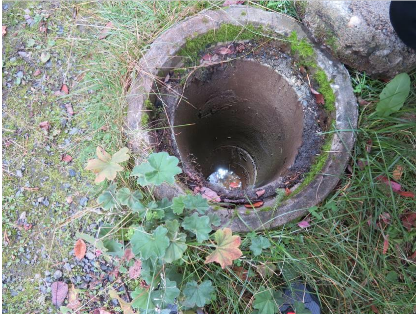
Kuva 31: Salaojakaivo rakennuksen lounaiskulmalla.
