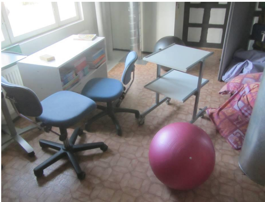
Kuva 21: Toisen kerroksen vanha huonokuntoinen matto.
