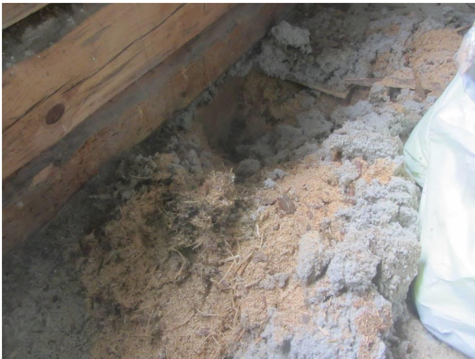
Kuvat 19: Yläpohjan rakennekerroksia
