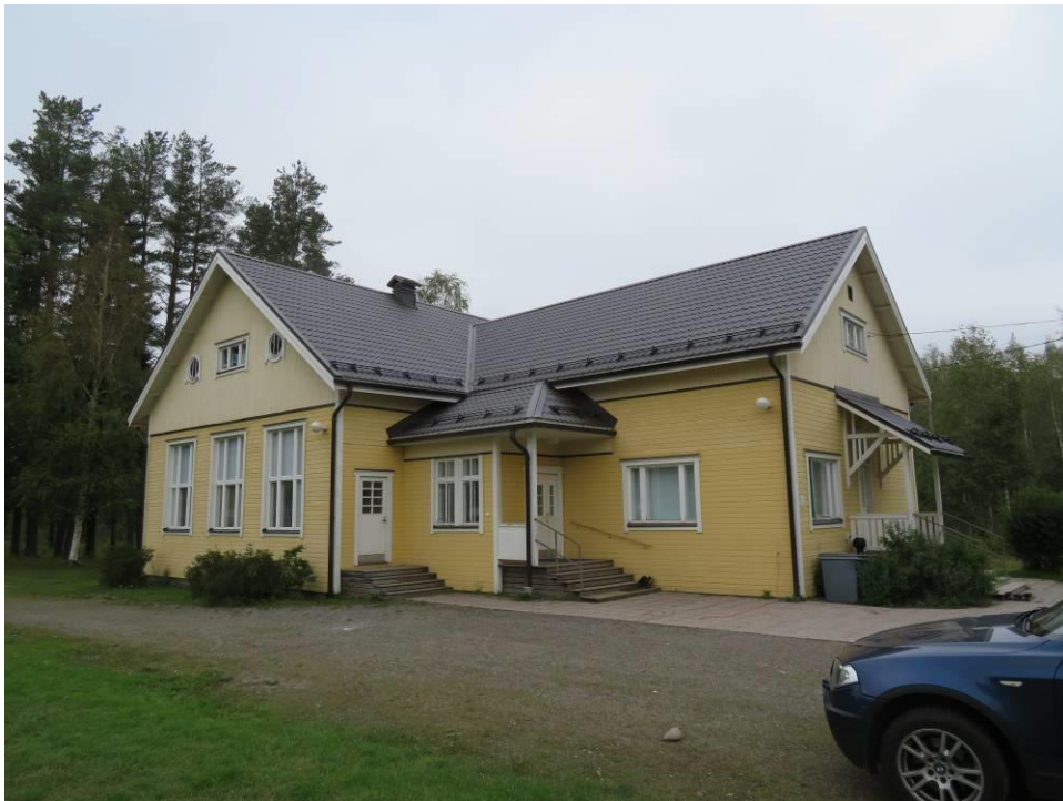
Kuva 22: Peltikate on silmämääräisesti arvioituna hyvässä kunnossa
