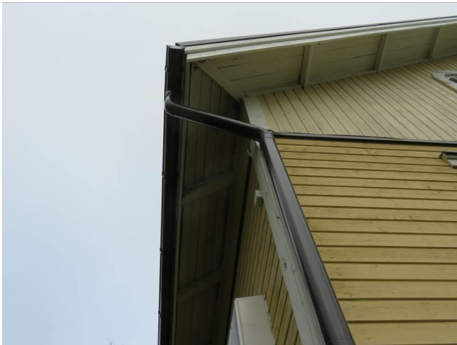
Kuvat 25: Sadevesikouruja ei päästy tarkastamaan, mutta silmämääräisesti arvioituna vedenohjaus toimii.
