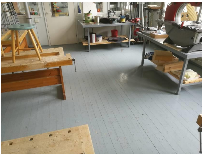
Kuva 18: Teknisentyönluokan maalattu lankkulattia
