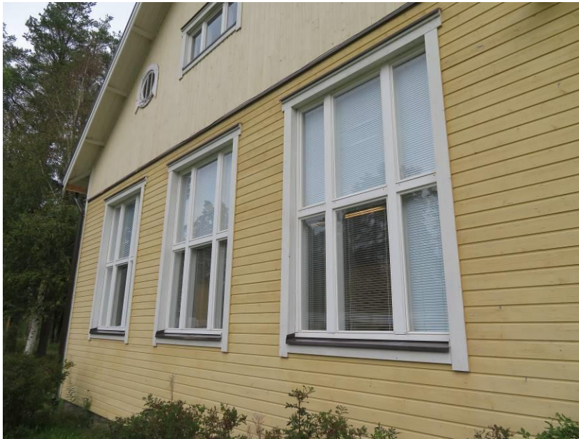
Kuva 11: Julkisivuverhouksena maalattu puuverhous
