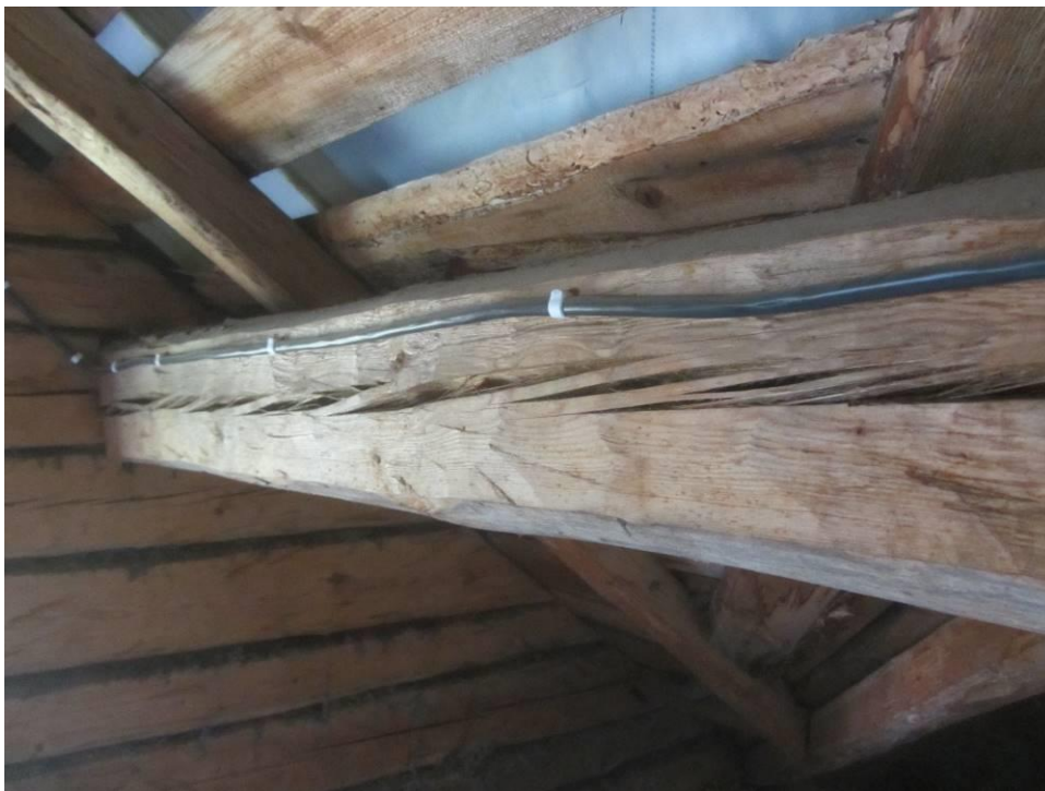
Kuva 21: Hirsirungon halkeilua
