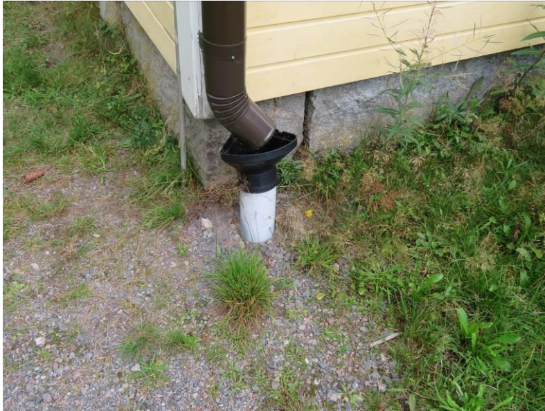
Kuva 26: Sadevedet on asianmukaisesti ohjattu rännikaivoihin.
