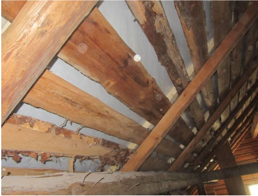
Kuva 20: Vesikate on uusittu ja puuosat ovat hyväkuntoisia.
