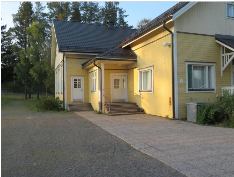
Kuva 27: Katon lumiesteet ovat silmämääräisesti arvioituna hyväkuntoiset. Katolla ei ole kulkusiltoja.
