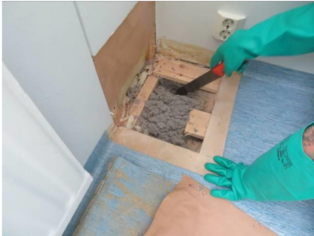
Kuva 9: Alapohja-avaus esiovetustilassa
