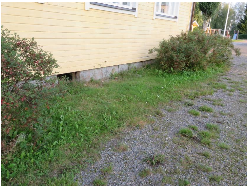
Kuva 29: Rakennuksen seinustoilla on pensaita sekä takapihalla on puita lähellä rakennusta.
