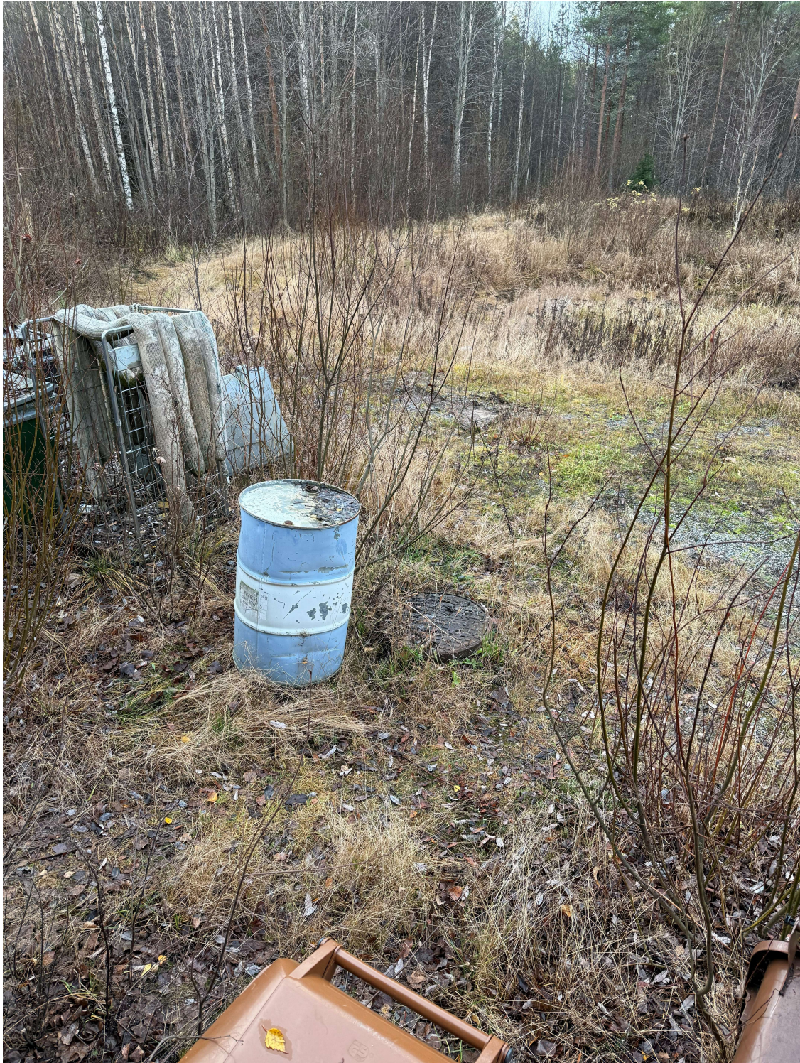
Kuva 6. Puhdistamorakennuksen pihalla olevasta pumpppukaivosta lähtee PEH 90-paineviemäri Lestijärvi-Kinnula siirtoviemärin lähtöpumppaamolle. Vääpätty sako- ja umpikaivoliete voitaisiin johtaa tätä putkea pitkin siirtoviemäriin.
