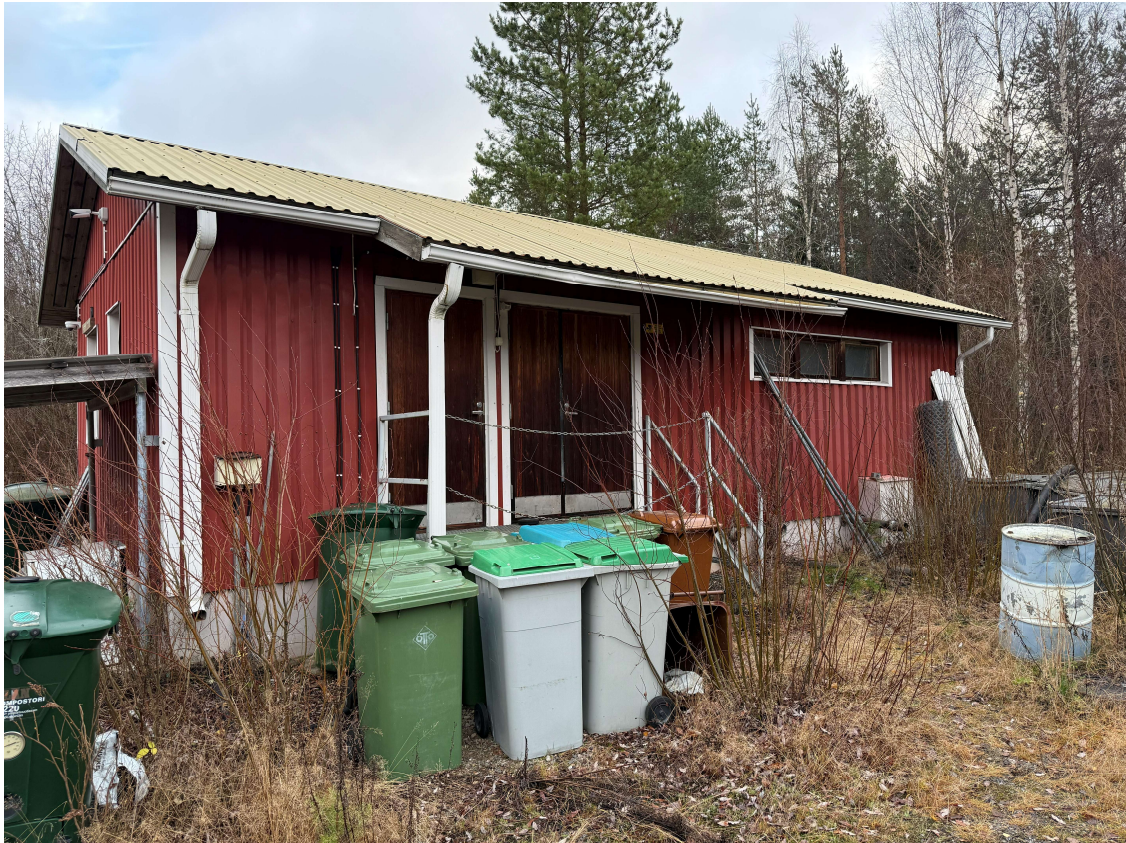
Kuva 4. Vanhan puhdistamorakennuksen yleiskuva.
