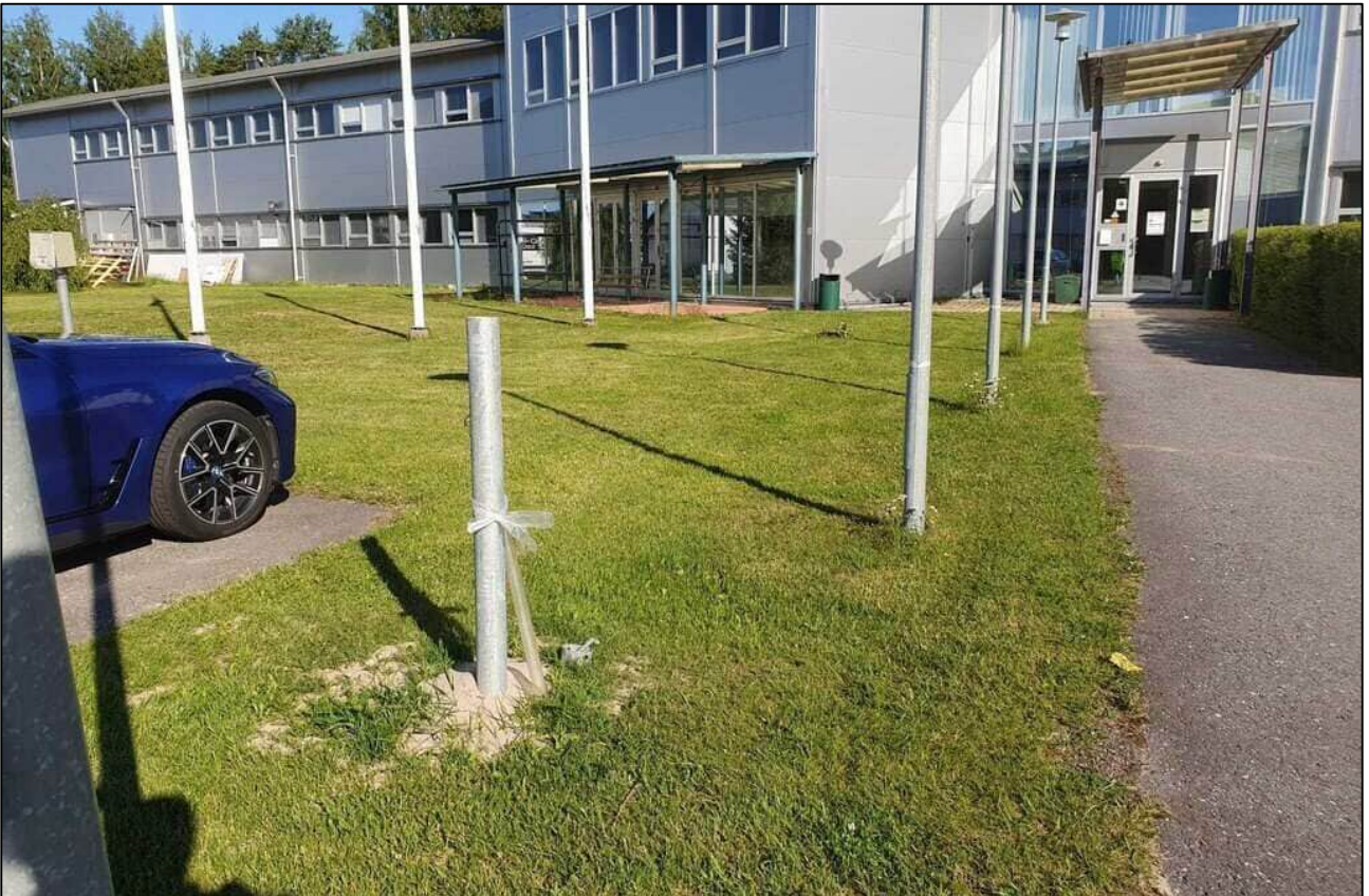
Kuva 10. Pohjavesiputki PVP3.
