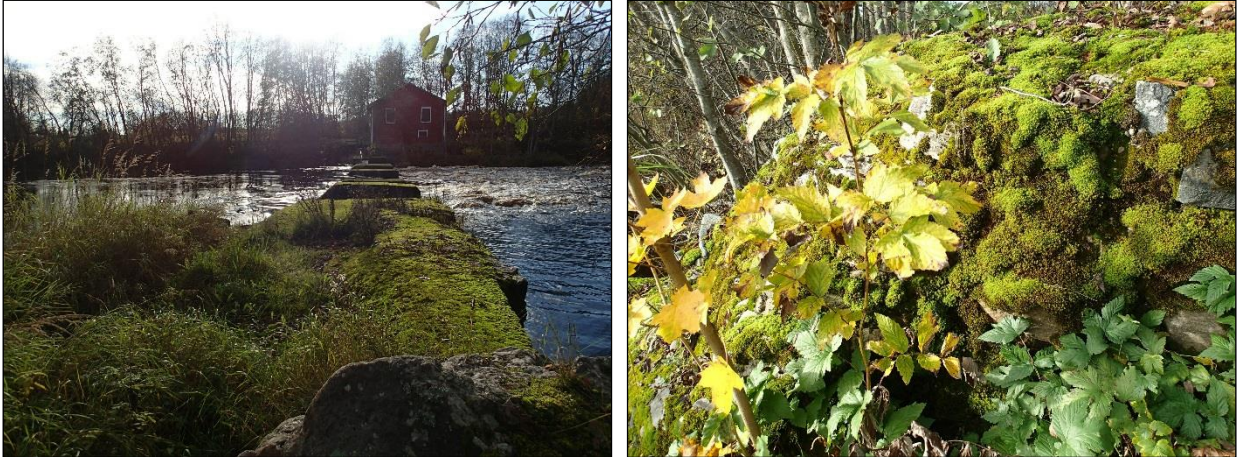
Vasemmalla betonirakenteista myllypatoa kuvattuna kohti vanhaa myllyrakennusta, oikealla rannalla kivistä tehdyn rakenteenteen jäännöksiä.
